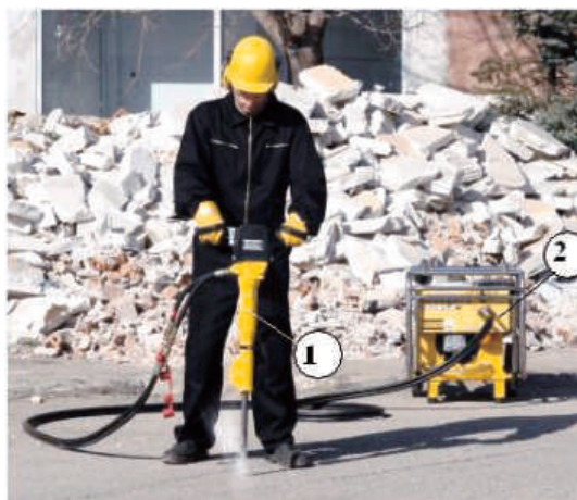
Сл.31. Работа со хидрауличен откопен чекан: 1. хидрауличен откопен чекан, 2. хидрауличен агрегат.
