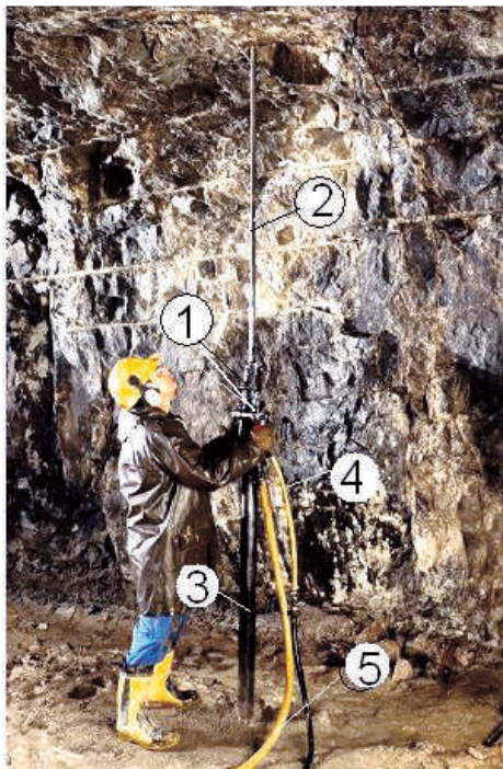
Сл.54 . Изработка на дупки за сидра во ходник со ускопен дупчачки чекан:
