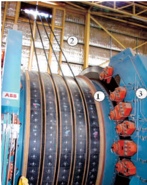
Сл.160. Извозна машина со тапан „Кепе“ поставена од страна на извозната кула: 1.тапан; 2.извозни јажиња; 3.кочница.
